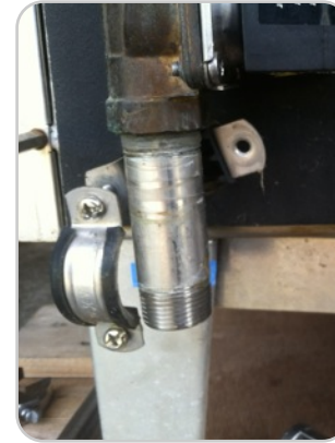
Step 4: Unhook clamps Unhook the mounting clamps
